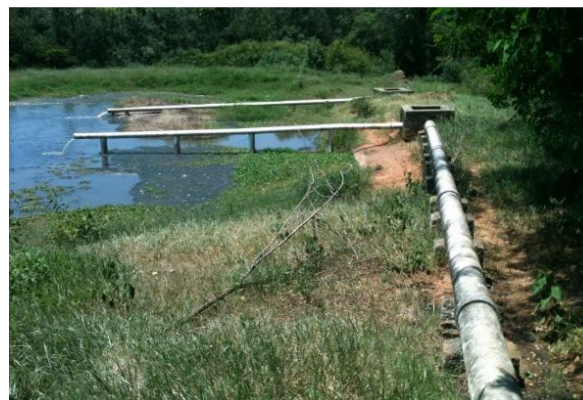
Vista geral da lagoa anaeróbia
