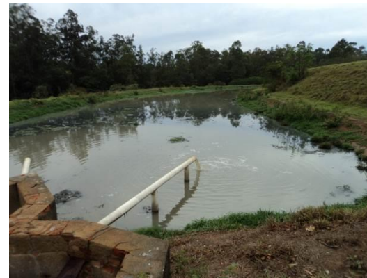
Vista geral da lagoa facultativa 1
